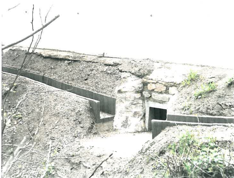
Obr. 7: Podchod v hrázi Chlumského potoka s naváděcími žlaby
