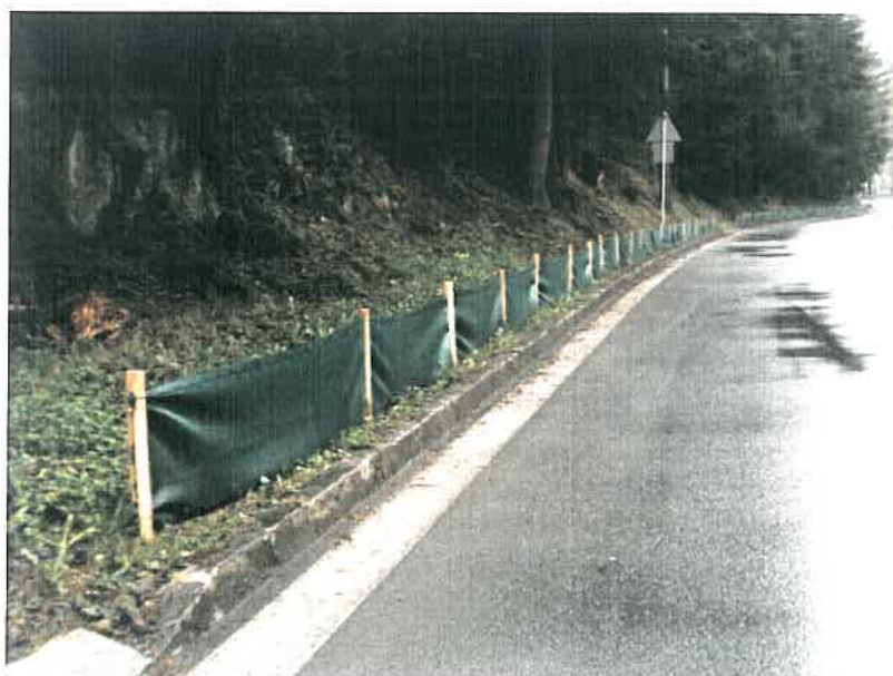
Obr. 9: Dočasné textilní naváděcí zábrany
