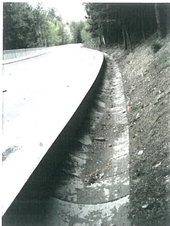
Obr. 8: Naváděcí příkop s kolmou přední stěnou
