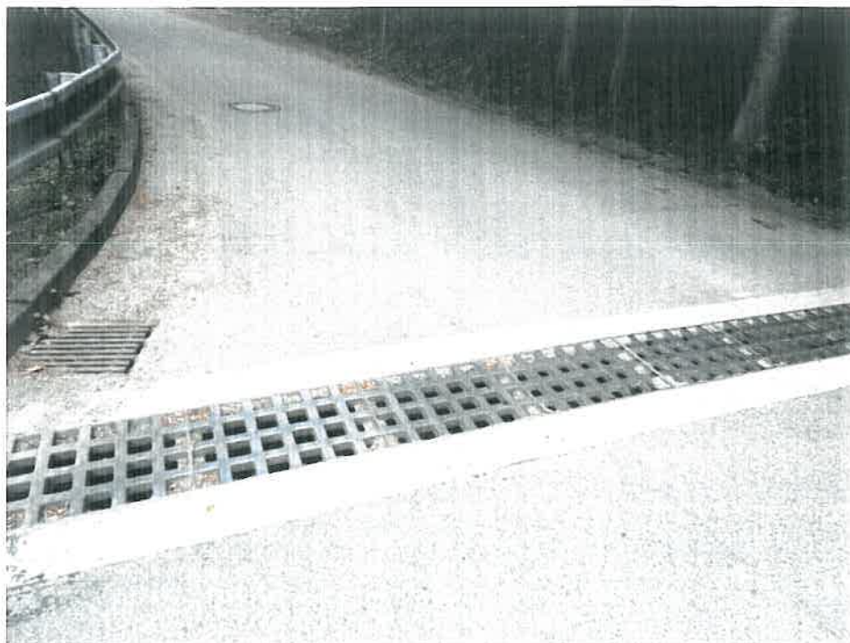
Obr. 6: Propadávací rošt na silnici od Chlumu
